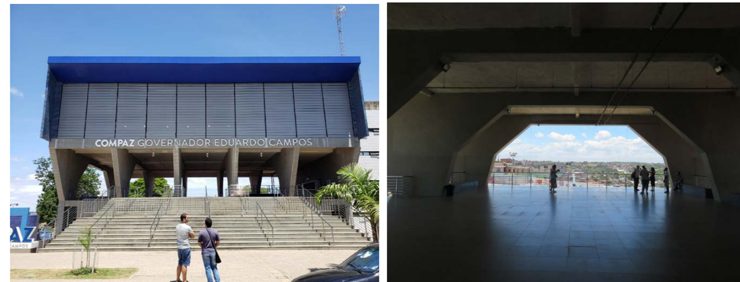
Figura 4. COMPАЗ Santa Terezinha, fachada norte (izquierda) y plaza interna (derecha). Fotografías: Autor.
