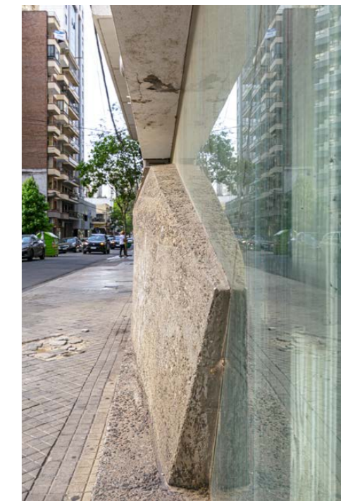
Imagen actual de la pedra sobre fachada calle Mitre.
