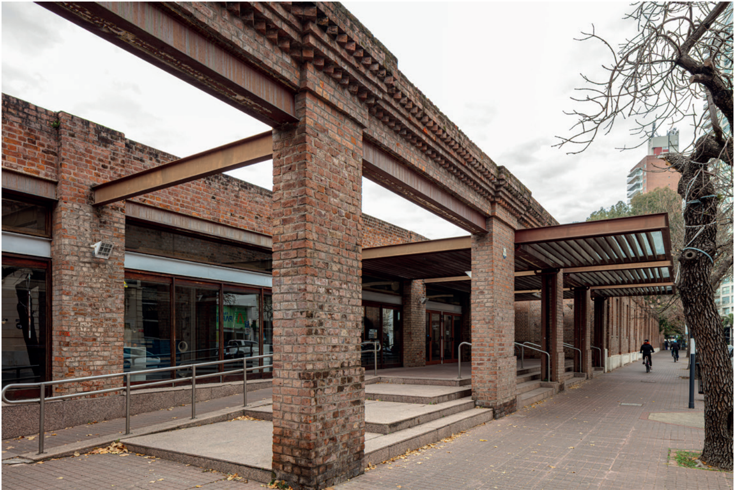
Arriba: corte por el ingreso estado actual. | Abajo: fotografía del ingreso principal al CMD Centro.
