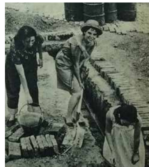
Figura 6. Jóvenes del CUT colaborando a techar una vivienda. Fuente: "La juventud se moviliza para ayudar al país" (1967, p. 5). Gentileza de José Zanca. | Figura 7. Mujeres trabajando en el zanjeo para cimientos de una vivienda. Fuente: "La juventud se moviliza para ayudar al país" (1967, p. 6). Gentileza de José Zanca
