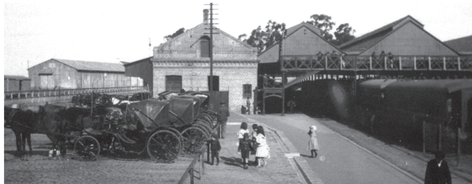
Arriba: planimetrías de la obra en el estado previo a la intervención (1998). | Abajo: F.C.C.A. Estación Rosario Central. Colección Lacassin (1907). Fuente: Archivo de Fotografía de la Escuela Superior de Museología.
