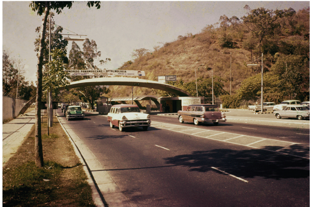
Figura 10. Arriba: Caseta de vigilancia con alero. Fuente: Memoria y Cuenta del Ministerio de Obras Públicas, República de Venezuela, ca. 1954-56. Abajo: Acceso con arco estructural. Fuente: Fundación Villanueva.
