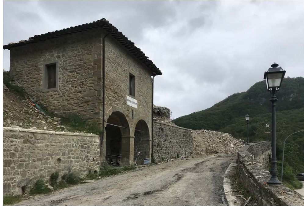
Figura 4. La strada di accesso ad Arquata del Tronto e l'individuazione dell'Ufficio Turistico, unico edificio sopravvissuto al sisma. Fonte: Foto degli autori.
