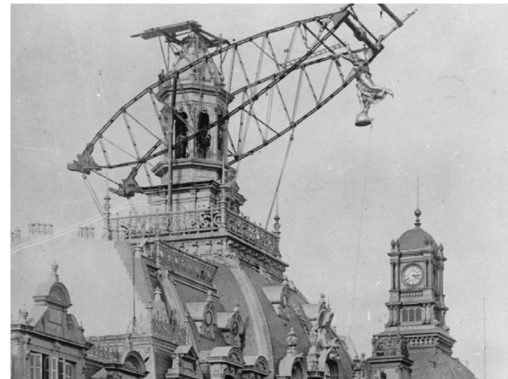
Figura 11. La escultura alegórica de La Prensa a poco de ser colocada en la cúpula de la flamante sede con un sistema diseñado por Carlos Agote. Fuente: La estatua de La Prensa (1898, noviembre 12, p. 13).
