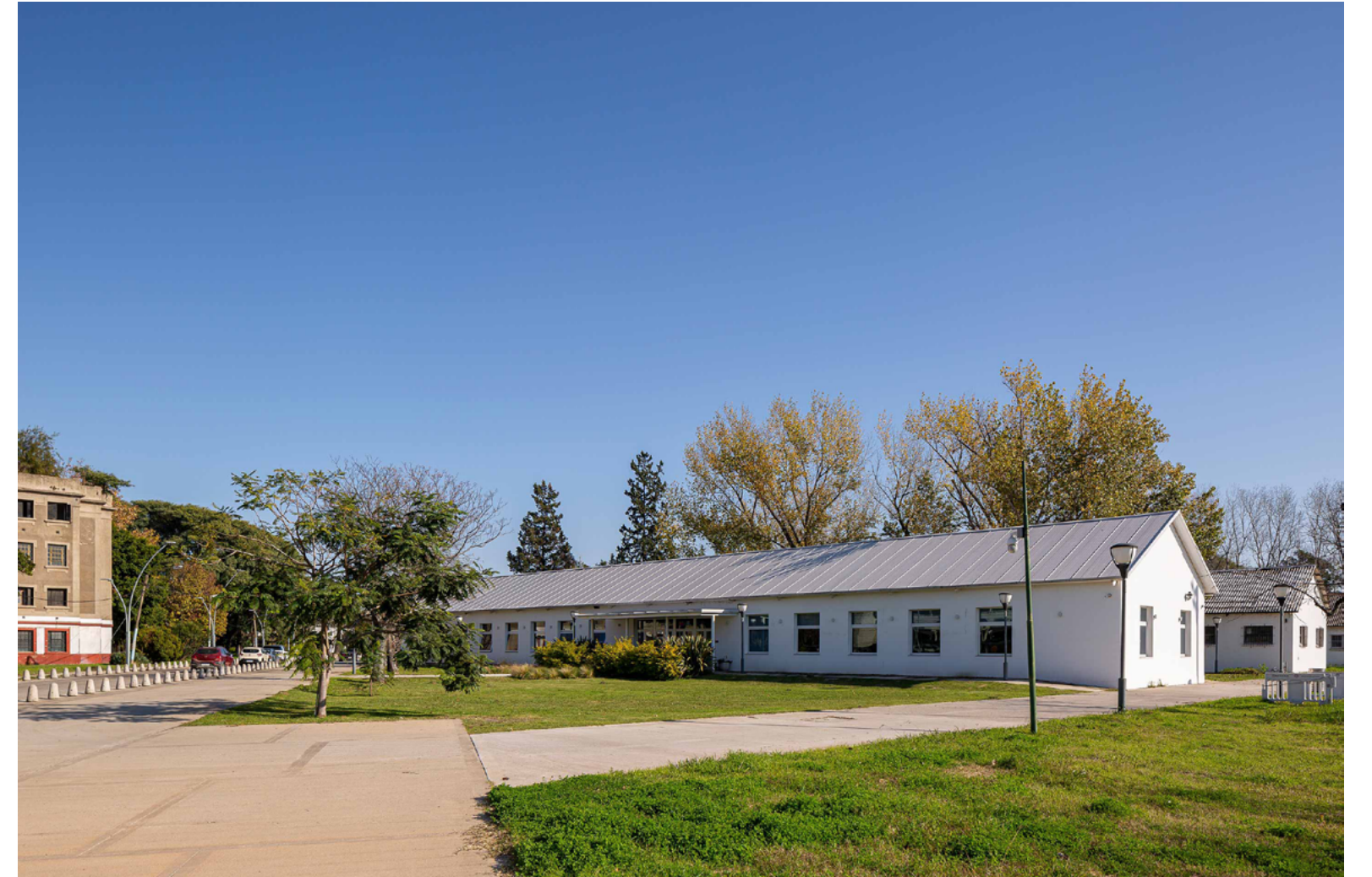
Vista sector polo tecnológico - Zona i Uso original: dormitorios militares. Uso actual: Espacio Maker, coworking
