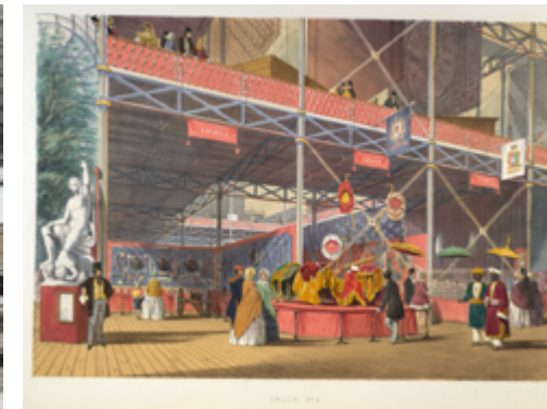
Figura 5. The Station at Euston Square (aguafinta coloreada de J Harris sobre dibujo de T. Bury, impreso por Ackerman, CL-SAC, 1937). Fuente: London and Birmingham Railway. http://www.crht1837.org/history | Figura 6. Crystal Palace. Cerchas de doble diagonal y los tensores diagonales de refuerzo (que no estaban en el diseño original). Fuente: Victoria and Albert Museum. https://www.vam.ac.uk/
