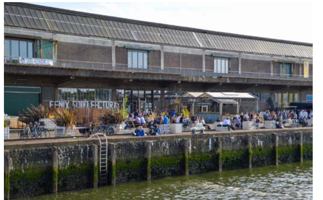
Figura 5. Markthal, MVRDV. Rotterdam. 2014. Fuente: https://www.mvrdv.nl/projects/115/markthal .
