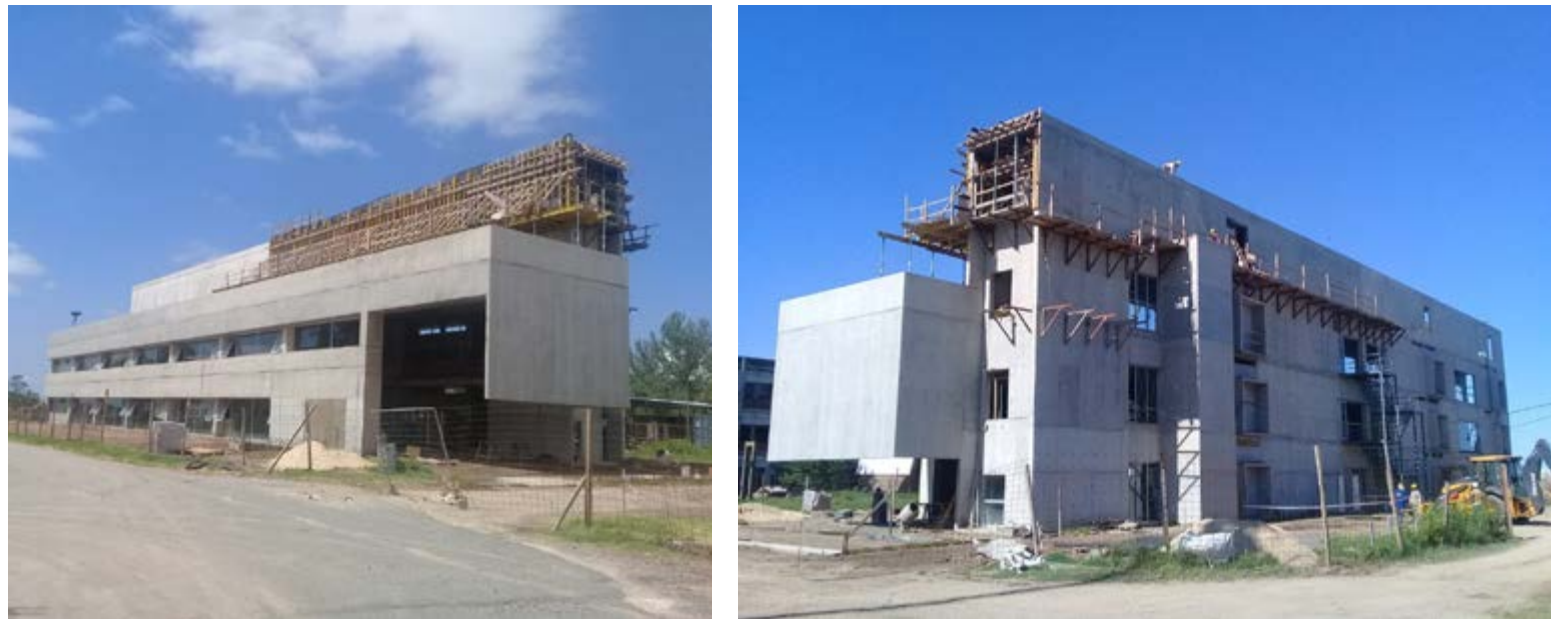
Figuras 6 y 7. Edificio de Investigación e Innovación para el Desarrollo de la UNR. Etapa 1. Fuente: Dirección de Construcciones Universitarias - Secretaría de Infraestructura Universitaria - UNR.
