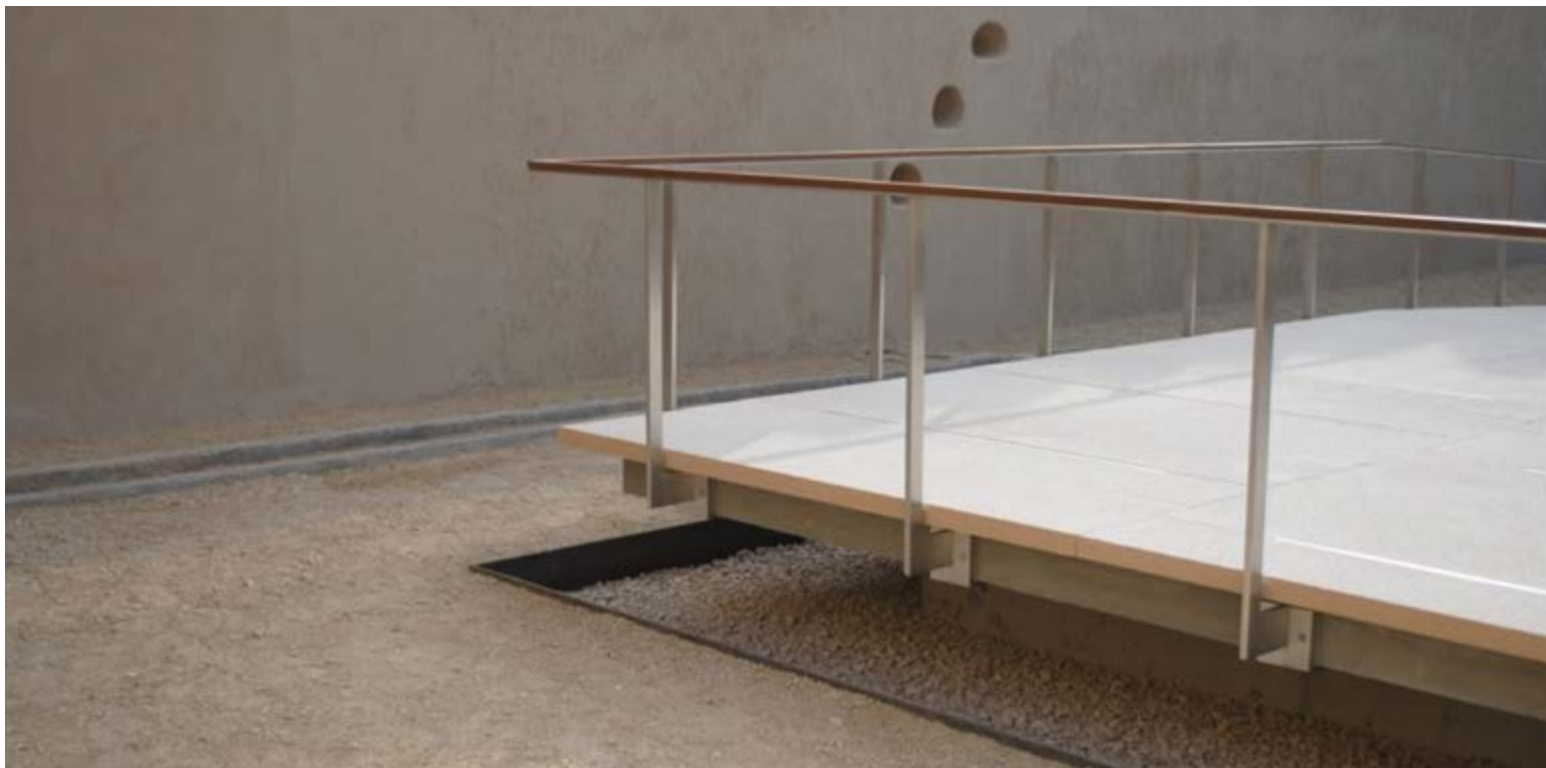
Qasr Al Muwaiji - Detalle de la rampa de acceso al nuevo Museo en Qasr Al Muwaiji.
