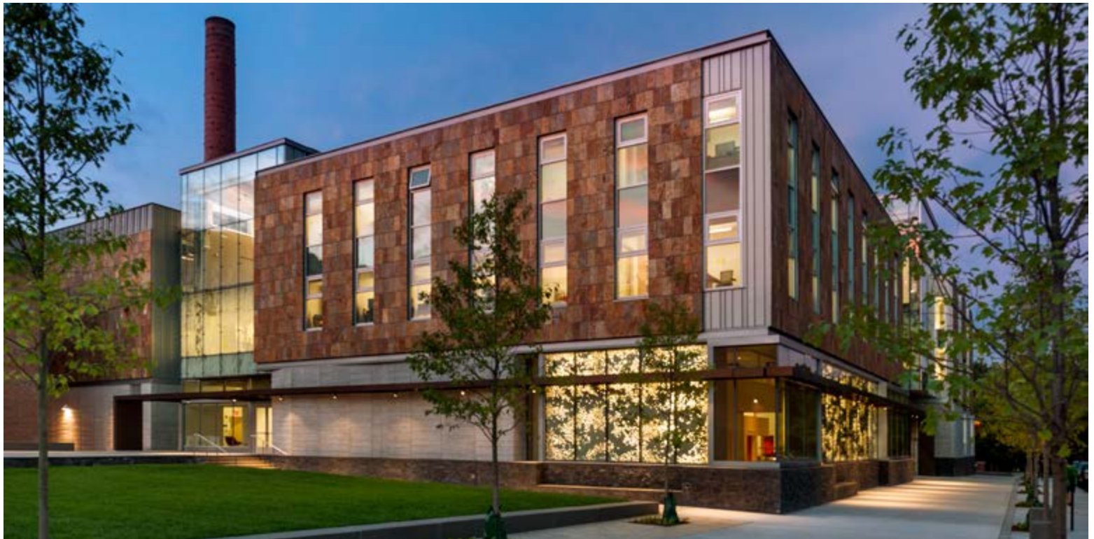
BFVAC. Vista del ángulo Sud Este del BFVAC adonde se encuentra la Galería de Arte, sobre la Calle Lebanon
