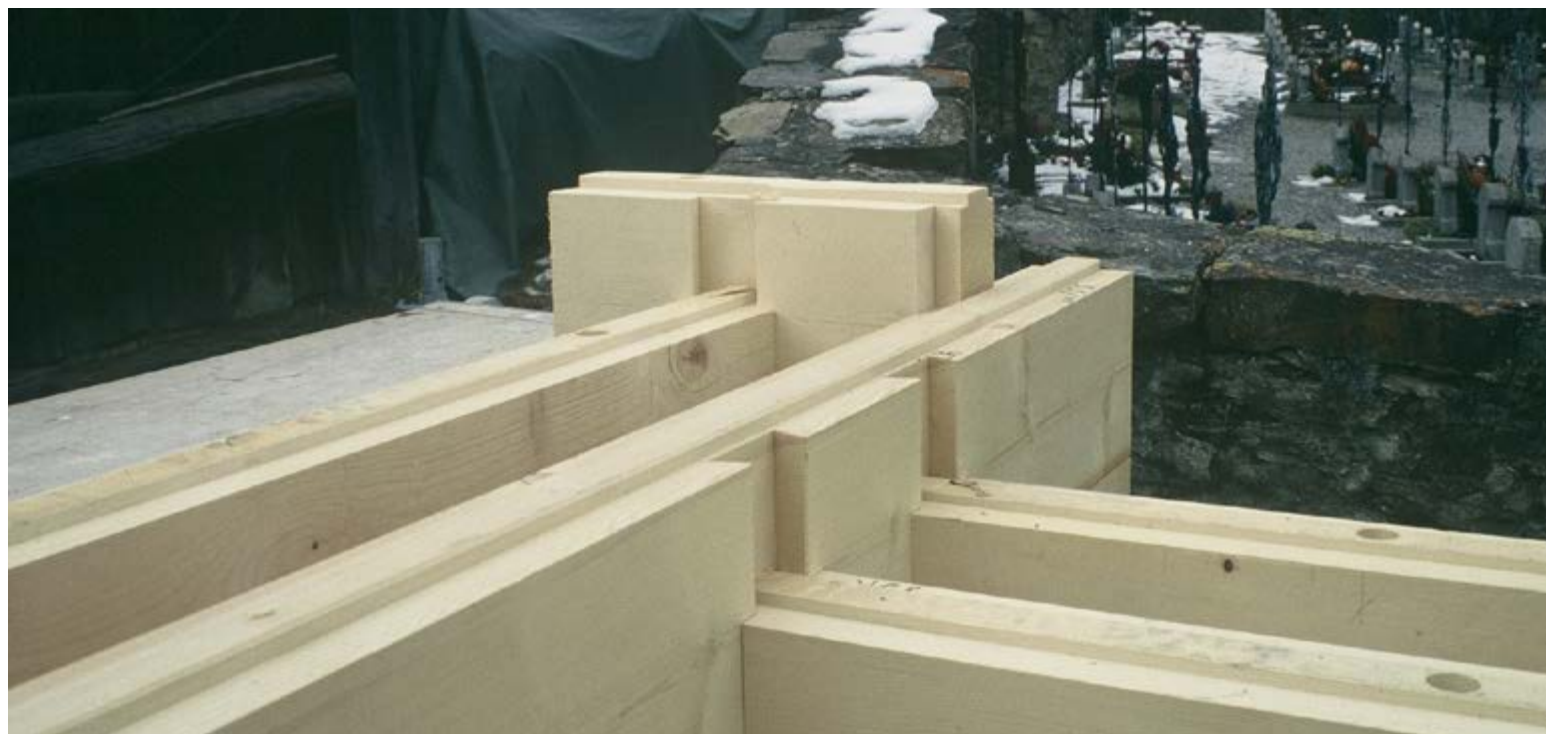
Detalle de obra. Foto: Estudio Caminada-Vrin
